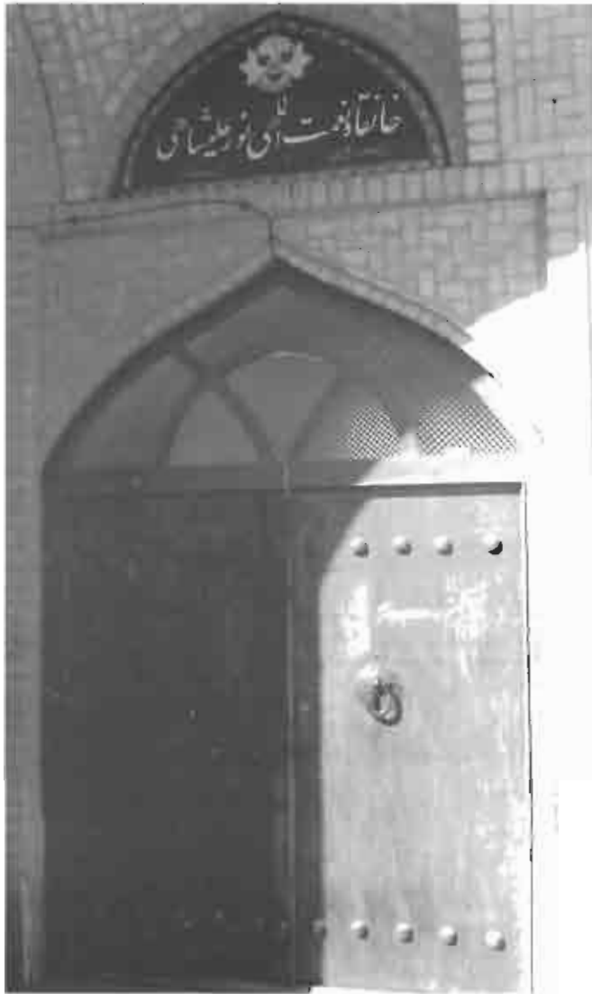
ورودی بنای قدیمی بازسازی شده خانقاه نعمت الهی کرمان
