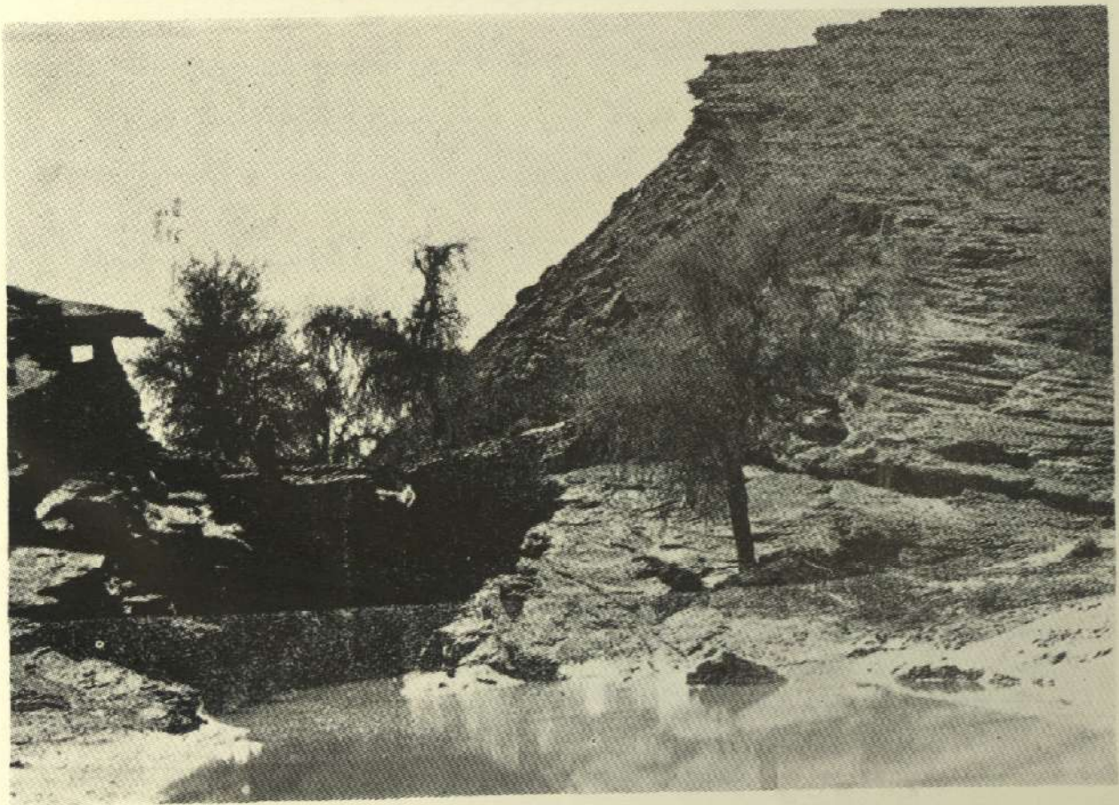
شکل ۸- نمایش دیوار سد دم از جانب شمال و آبریز آن (عکس از نگارنده)
