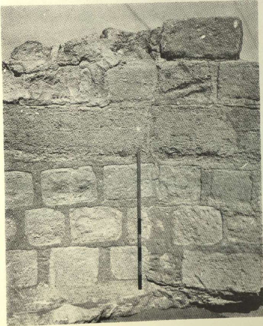
شکل ۶ - نمایش سنگهای بکاررفته در پایه سنگی سد تل بالا «جزیره قشم» (عکس از نگارنده)
