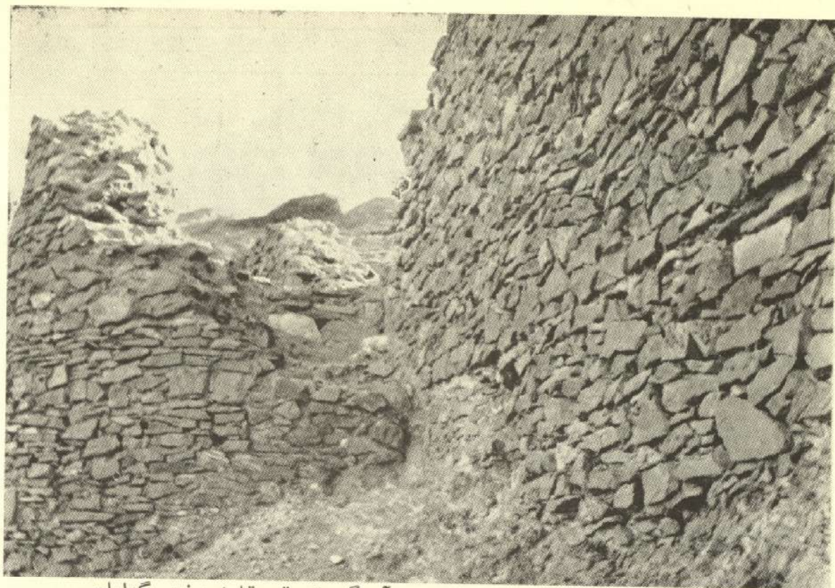
شکل ۳ - دیوار و پلکان سمت غرب برآمدگی شرقی قلعه دختر گناباد . پلکان از جنوب وارد نیم برج مدور میشود و به راهرو مسقف راه میدهد
