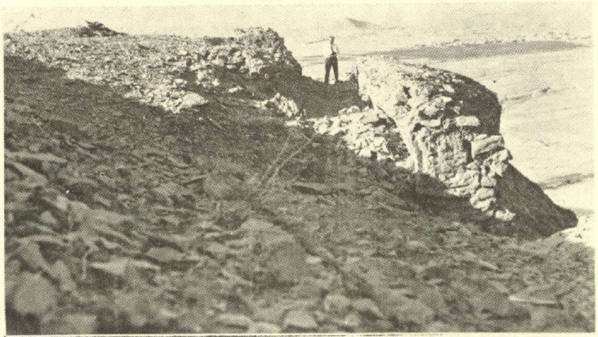
شکل ۲ - معبر مسنقف برآمدگی شرقی قلعه دختر شوراب گناباد که در عین حال آب قسمت های شرقی و شمالی قلعه را بخارج هدایت میکرده است .
