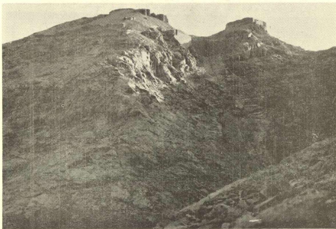
شکل ۶ - منظره برآمدگی شمالی و غربی قلعه دختر شوراب گناباد و بقایای ساختمانی آن در بین دو برآمدگی فاصله ای که با ساختن سه دیوار سنگی در جنوب آن برای تسهیل عبور و مرور ارتباط در قسمت قلعه بوجود آمده دیده میشود
