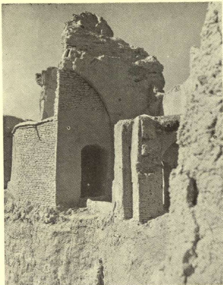
تصویر ۵ - این تصویر ورودی چهارطاقی و مسجد کنونی و قسمتی از دیوار شرقی آنرا که پس از ریزش بدنه صخره در چند سال پیش دوباره سازی شده است نشان میدهد.
