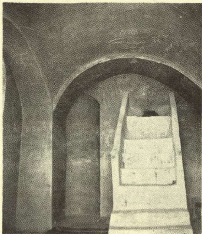
تصویر ۶ - تصویری از داخل چهارطاقی پس از تبدیل آن بمسجد. چنانکه مشاهده می شود در زیر گنبد اصلی چهارطاقی، پوشش کم خیزی را برپا کرده اند و سپس در ضخامت دیوار جنوبی چهارطاقی بعد از بستن طاقنمای میانی آن، محرابی ساده ایجاد کرده اند و بالاخره منبری در کنار آن ساخته اند. (عکس از نگارنده)
