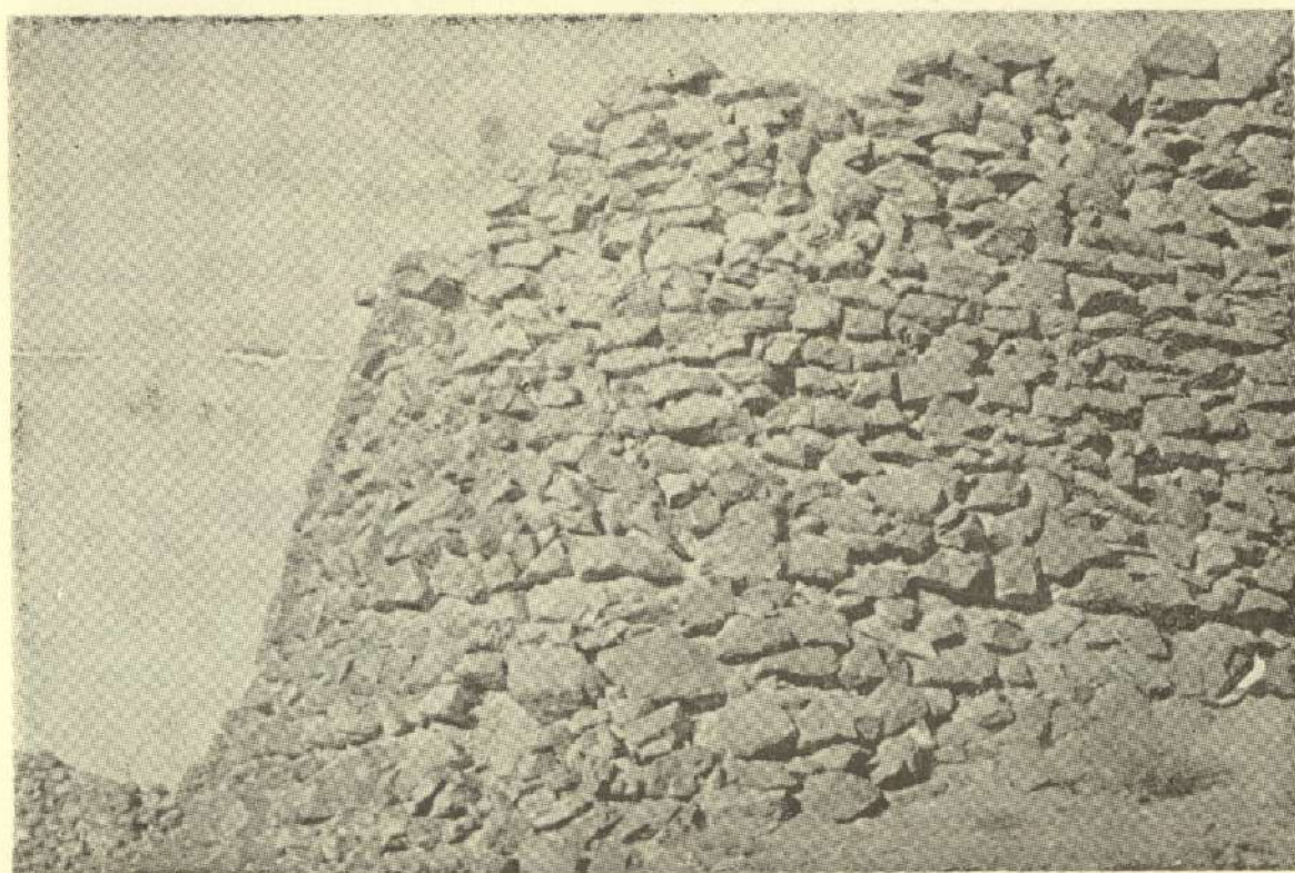
شکل ۴ برج گوشه جنوب غربی قلعه مخروبه زبید گناباد (۶)
