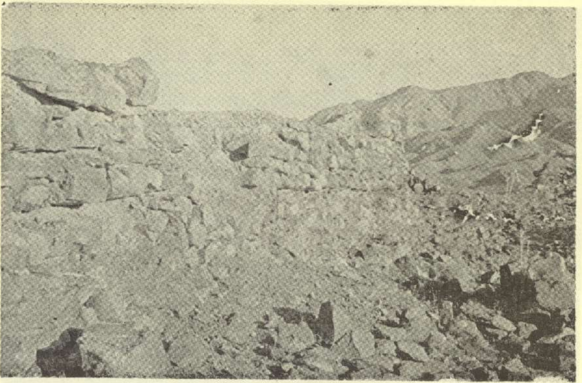
شکل ۵ دیوار شمال قلعه مخروبه زبید گناباد از داخل .
