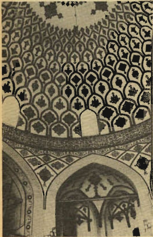
تزیینات عرفه‌ها و قسمتی از گنبد و کاشی‌کاری روی رسته گنبد
