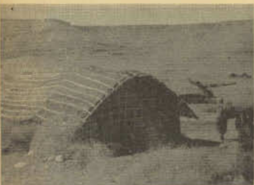
نونه خانه‌هایی که مردم لرستان در زمستانهای گرمسیری بر پا میدارند و آن را کپسیر می‌نامند که بر آن ایلیاتی‌گانه‌ای که در مردمانها می‌روید می‌سازند. و درون آن نسبتاً خشک است
