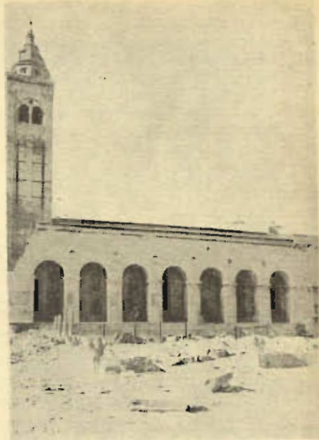
تصویر ۱۶ - معبد سن فرانسوا در «ری می» ایتالیا - یکی از دیوارهای برشته شده پس از آسیب
