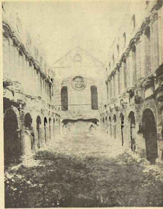
صویر ۱ - کلیسای سان‌کیارا در تریویل بر سر آلب‌سوزی - هنگام تعمیر این کلیسا دیگر طاق متعلق به قرن هجدهم را که در تصویر شماره ۳ می‌بینیم از نو ساختند بلکه فقط پوشش طرح قدیم را زنده کردند. همچنین تزیینات شده باروک دیوارها را نیز کنار گذاشتند
