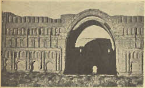
۷ - دیواره سازی شده ایوان غربی کاخ اشکانی آشور.
