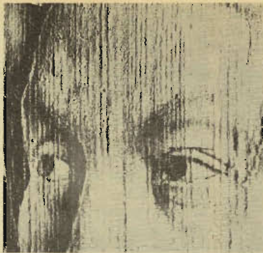
فرسك دیواری که در نتیجه رطوبت آسیب دیده است
