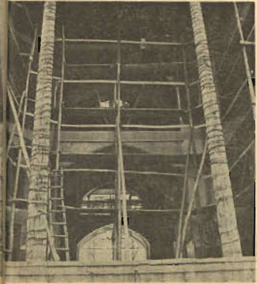
ایوان غربی کاخ هشت‌بهشت در حال تعمیر (اردیبهشت ۱۳۵۱)
