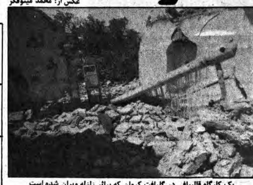
یک کارگاه قالببافی در گلپایگ کرمان که بر اثر زلزله ویران شده است
