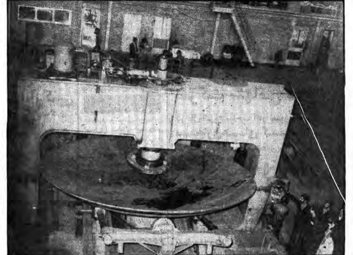
با دستگاه عدسی زنی در ماشین سازی اراک و با همکاری شرکت مخابرات در زمینه ساخت آنتن های مختلف می توان اقدام به ساخت آنها نمود.
